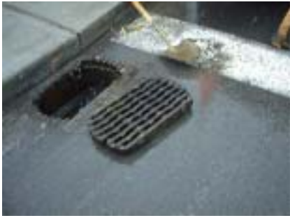
Figure 5: Grille rectangulaire à rainures parallèles et verrou à ressort
