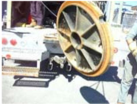
Figure 28: Soulèvement d'un tampon à l'aide d'un bras hydraulique muni de crochets
