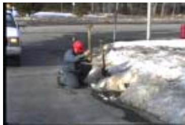
Étape 2: Détachement du couvercle de son cadre (ici avec une masse).
