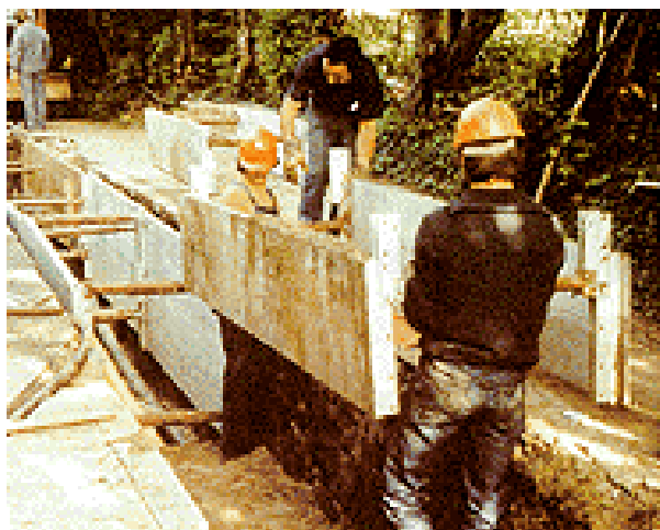
(a) Assemblage du caisson
