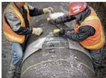
La couche est placée autour du joint et les courroies sont serrées.
