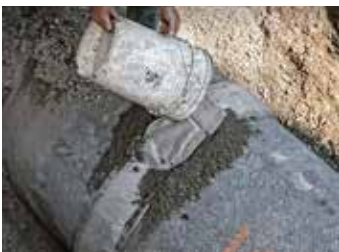
Le coulis est versé dans la couche d'un côté et ensuite de l'autre jusqu'à ce qu'elle soit complètement remplie
